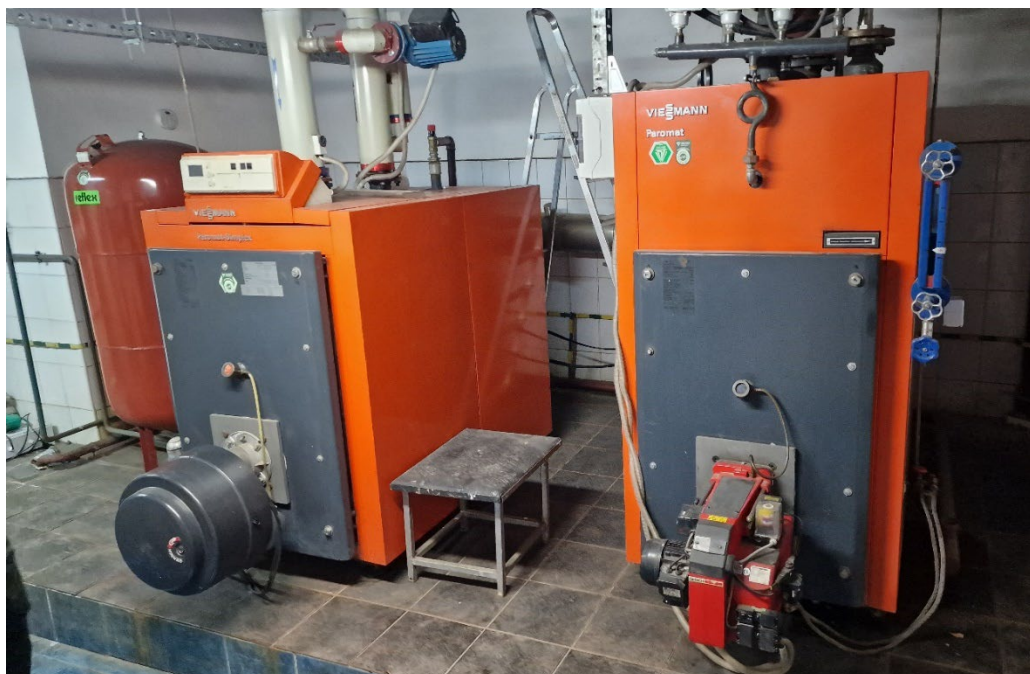
Zdj. 2 Pomieszczenie kotłowni, istniejące kotły olejowe.
